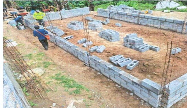
Foto 2: Mejoramiento de paredes a muros de block de la EORM Caserío Concepción las Flores
