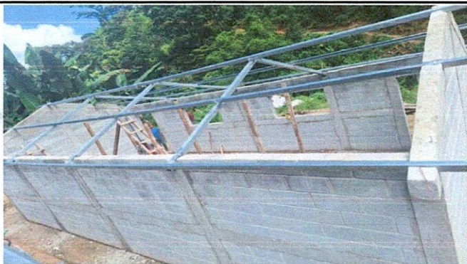
Foto 3: Mejoramiento de la estructura del techo de la EORM Caserío Concepción las Flores
